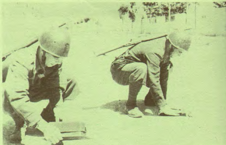
Rafforzamento di uno sbarramento stradale.
